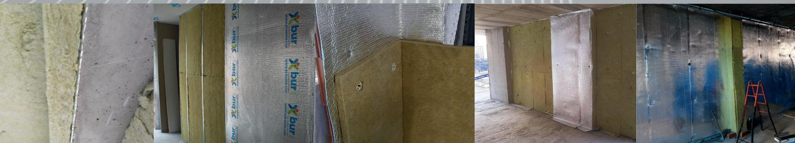
**AIR-BUR TERMIC CM Rock 70/6** es un aislamiento térmico que se divide en dos capas diferenciadas. La primera capa está formada por **lana de roca (RW)** de **60mm** y densidad **70 Kg/m³** la segunda capa formada por el Aislamiento Reflexivo **AIR-BUR TERMIC S**. Ambas capas se suministran por separado.
