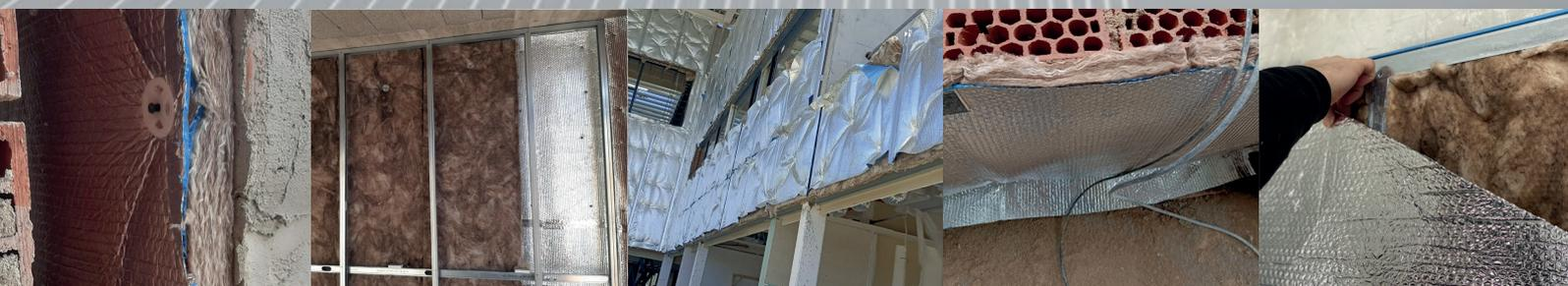
**AIR-BUR TERMIC CM MINERAL 54** es un aislamiento térmico que se divide en dos capas diferenciadas. La primera capa está formada por **lana mineral (MW)** de **50mm** y densidad **24 Kg/m<sup>3</sup>** la segunda capa formada por el Aislamiento Reflexivo **AIR-BUR TERMIC S**. Ambas capas se suministran por separado.
