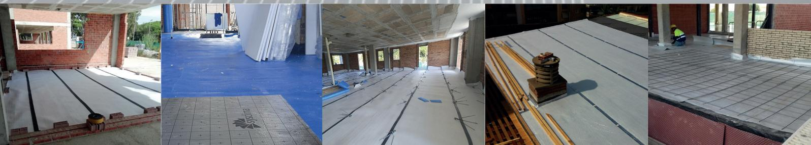
Air-bur Termic S-YC Pol 8mm es un aislamiento térmico multicapa que se divide en dos capas termoselladas. La primera capa está formada por una espuma de polietileno y la segunda capa formada por burbuja de aire encapsulado; ambas capas recubren entre sí, una lámina de poliéster de baja emisividad con alta propiedad reflexiva.
