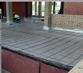
**Air-bur Termic S-YC 8mm** es un aislamiento térmico multicapa que se divide en dos capas termoselladas. La primera capa está formada por una espuma de polietileno y la segunda capa formada por burbuja de aire encapsulado; ambas capas recubren entre sí, una lámina de aluminio de baja emisividad con alta propiedad reflexiva.
