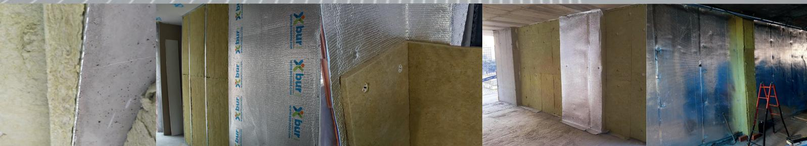
**AIR-BUR TERMIC CM Rock 45/6** es un aislamiento térmico que se divide en dos capas diferenciadas. La primera capa está formada por **lana de roca (RW)** de **60mm** y densidad **45 Kg/m<sup>3</sup>** la segunda capa formada por el Aislamiento Reflexivo **AIR-BUR TERMIC S**. Ambas capas se suministran por separado.
