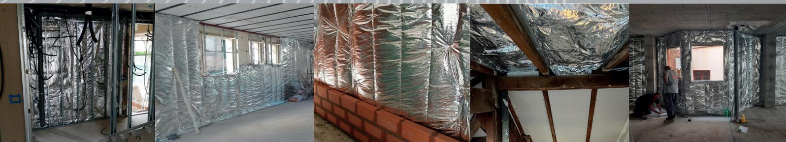
**Air-bur Termic 15** es un sistema de aislamiento reflectivo de innovación de 15 capas compuesto por: 2 láminas de poliéster metalizado armado, 2 guatas de poliéster, 6 láminas reflectoras y 5 espumas de polietileno de 1mm. Los cuales proporcionan una interfaz de baja emisividad en las cámaras donde se realice la instalación.
